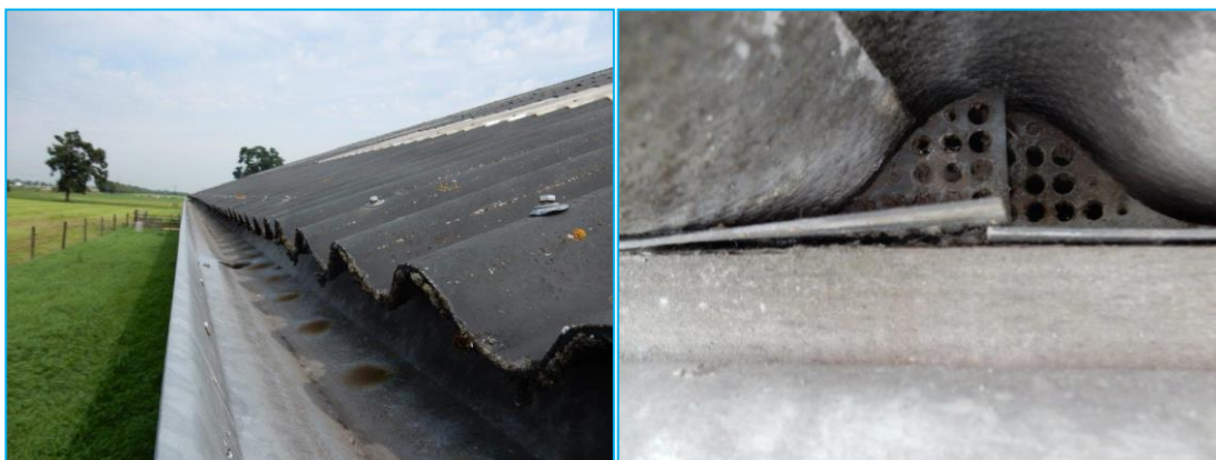
Foto's: Openingen bij golfplaten ontoegankelijk gemaakt door roosters.
