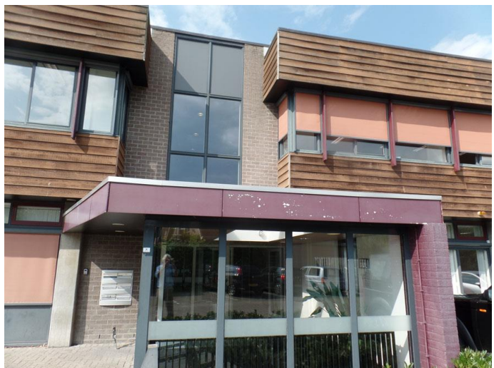
Figuur 8: Deel van de gevel met houten planken en bakstenen
