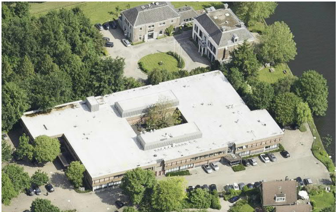
Luchtfoto van de bouwlocatie.
