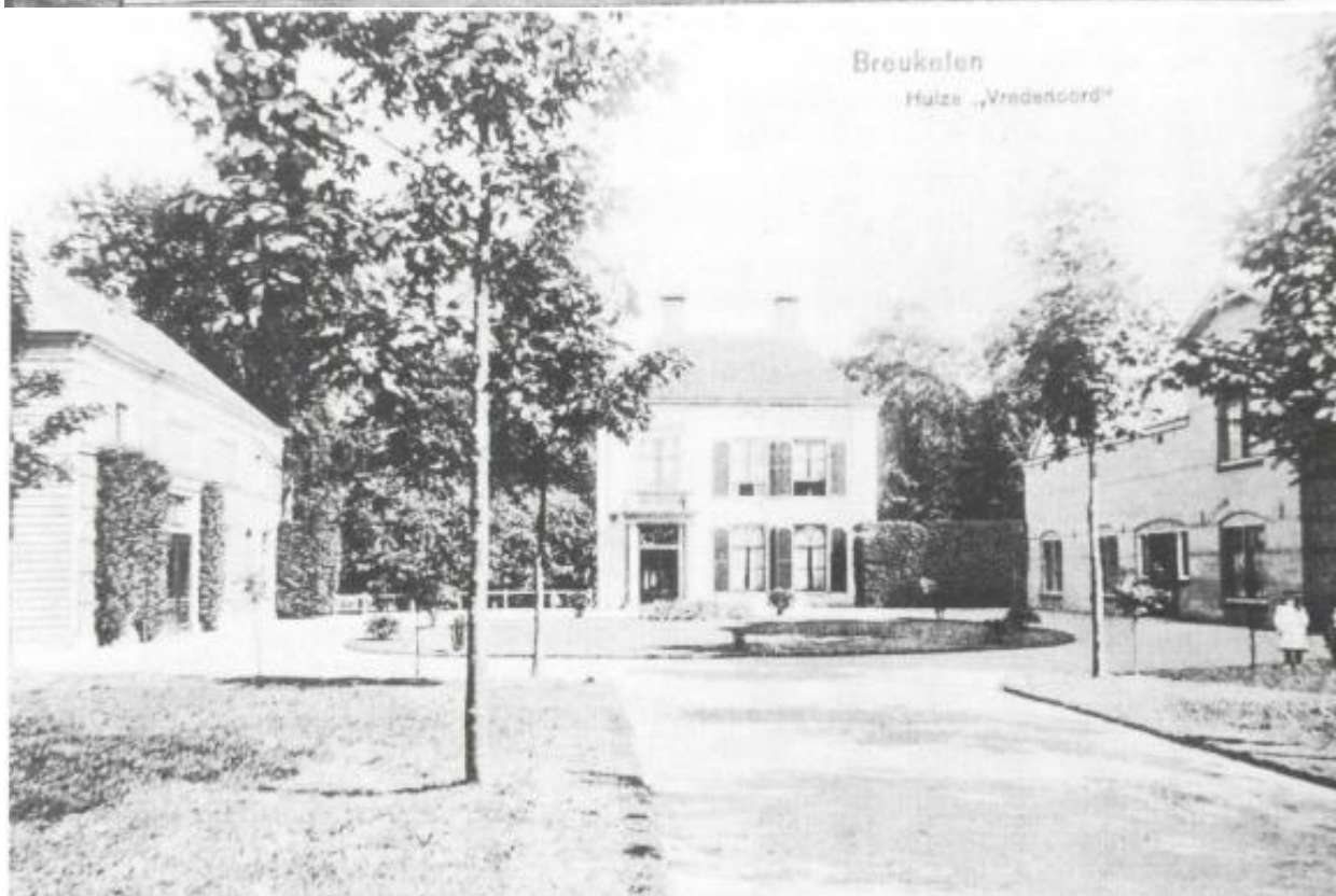
Vredenoord in de tijd dat het werd bewoond door de heer J.W. de Bruin, die er een Tabak en Sigarenfabriek exploiteerde. [THKB_2000-02_7]
