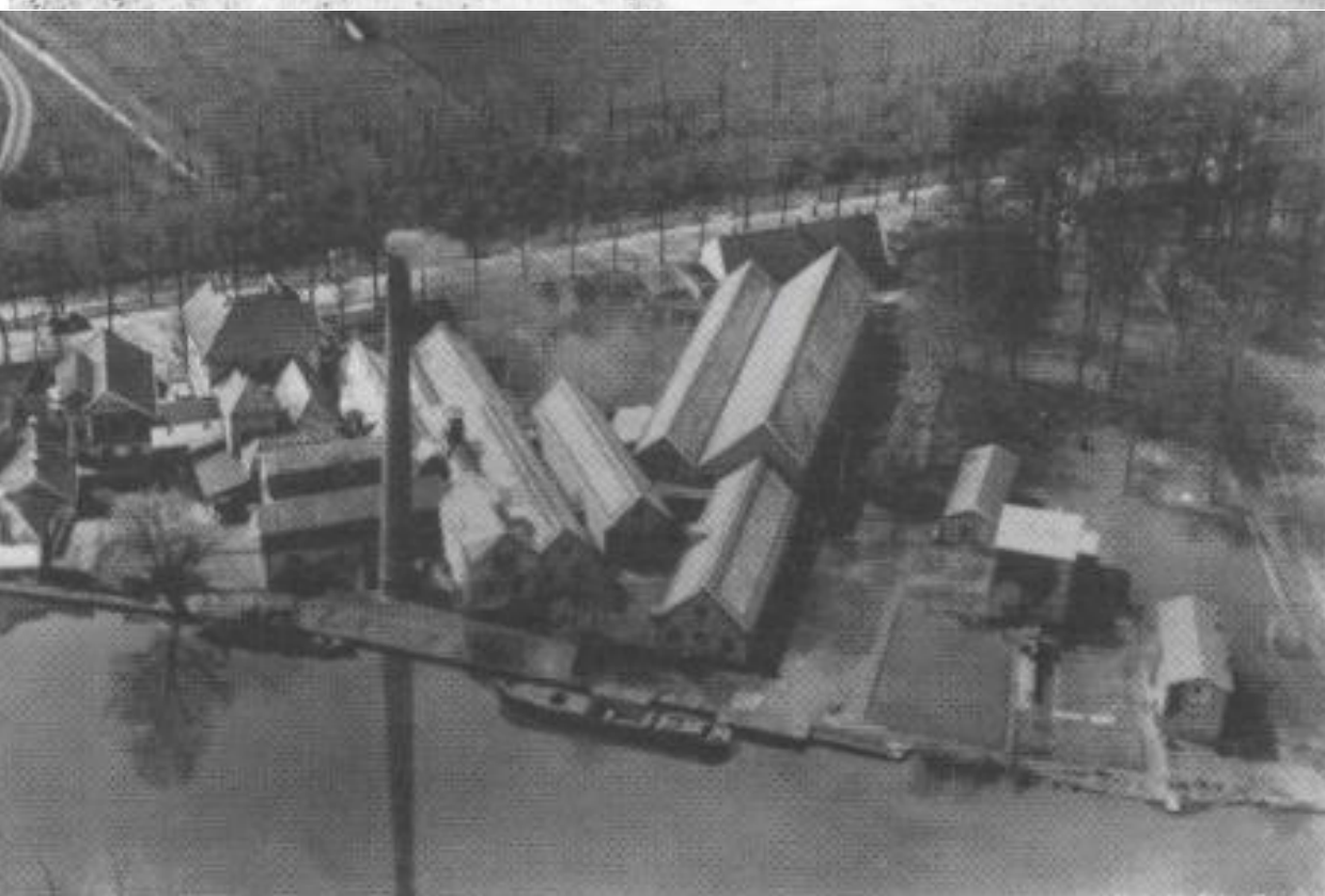
1928 – Luchtfoto van de melkfabriek Insulinde, ten zuiden van het plangebied. De losstaande gebouwtjes rechts staan op de grond die De Bruyn in 1899 verkocht aan de Nederlandsche Compagnie voor Aeroengeengas. Geheel rechts een afwateringssloot. [THKB_1996-05_1]
