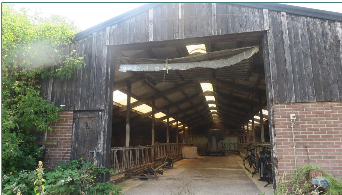
Figuur 1 De veestal welke zich bevindt op Scheendijk 3. In de beoogde ingreep wordt de stal gesloopt.
