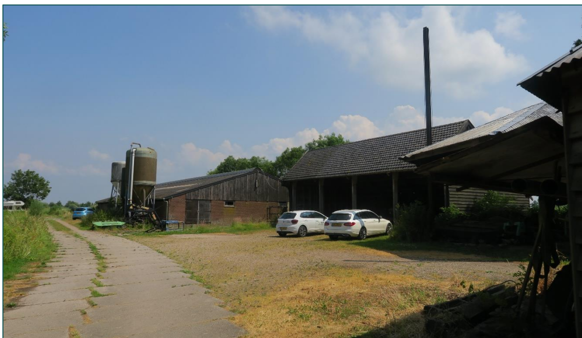
Figuur 1.4 Scheendijk 3 waarbij men voornemens is om agrarisch opstallen te slopen.
