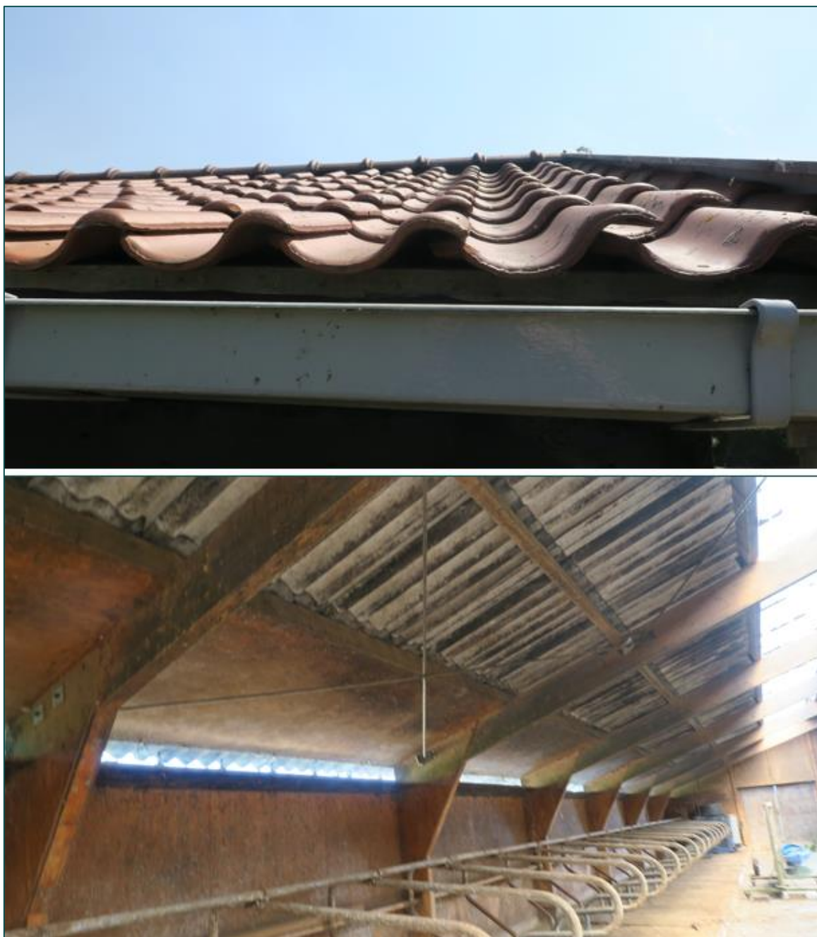
Figuur 3.2 Boven: pannendak van de garage. Beneden: dakbeschot in de veestal.
