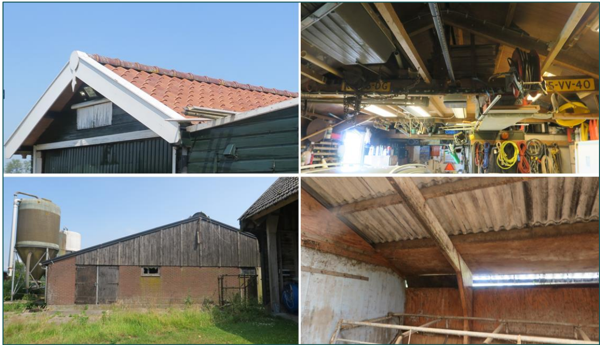
Figuur 3.1 Linksboven: garage met aansluitende pannendak zonder kieren. Rechtsboven: binnenzijde garage, welke niet geschikt is voor vleermuizen. Linksonder: De veestal waarbij in de muren geen openingen aanwezig zijn. Rechtsonder: dakbeschot in de veestal welke geen verblijfplaats voor vleermuizen vormt.
