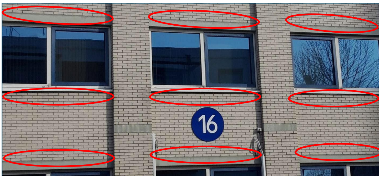
Figuur 8.18 Locaties van de open stootvoegen in het gebouw aan de Planetenbaan 16, welke mogelijk toegang geven tot geschikte verblijfplaatsen voor vleermuizen. In gebouw aan de Planetenbaan 15 bevinden de open stootvoegen zich op dezelfde plekken. (foto: RHDHV, 2021)
