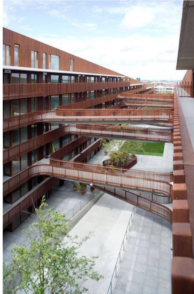
De bouwvolumes met een binnenhof bestaan uit galerijen met verbindingbruggen
