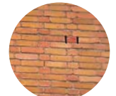
Toegankelijke spouw, voor vleermuizen
