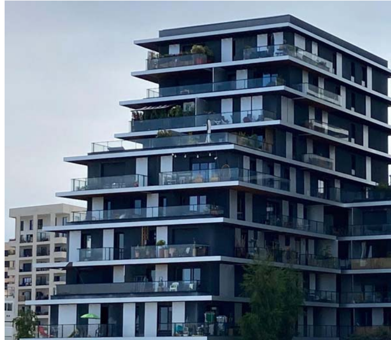
Het gebouw heeft een duidelijke horizontale geleding per verdieping en presenteert zich alzijdig.
