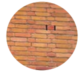
Toegankelijke spouw, voor vleermuizen
