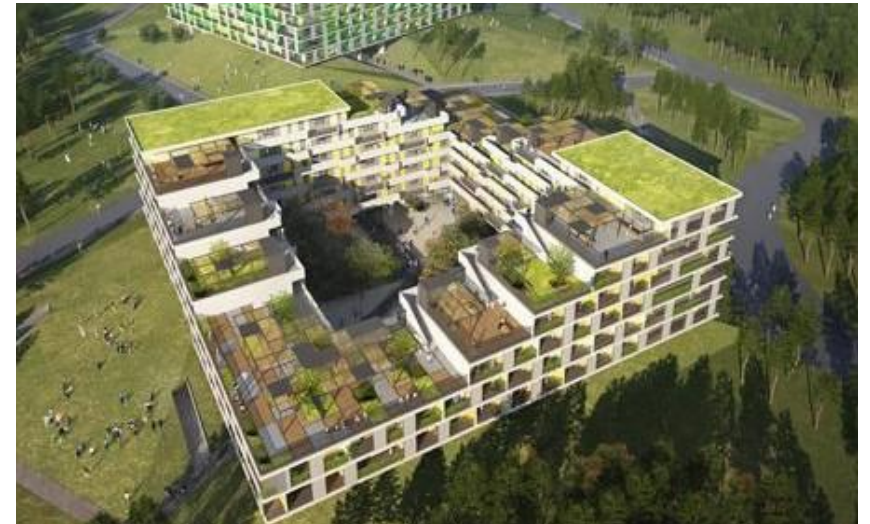
Het gebouw presenteert zich als een gestapeld landschap met terrassen, met een afbouw naar het binnengebied.
