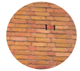
Toegankelijke spouw, voor vleermuizen
