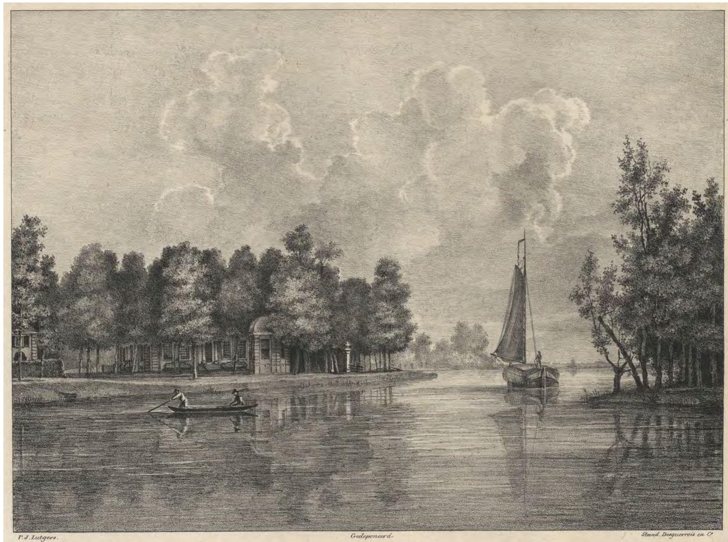
Gezicht op de Vecht bij Nieuwer- sluis op de buitenplaats Ouderhoek met de theekoepel, de poort en een aanleg in landschapsstijl in de omgeving van het huis. Vanuit het zuidoosten.
