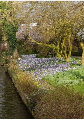
Kade bestaat uit een talud van zacht materiaal.
