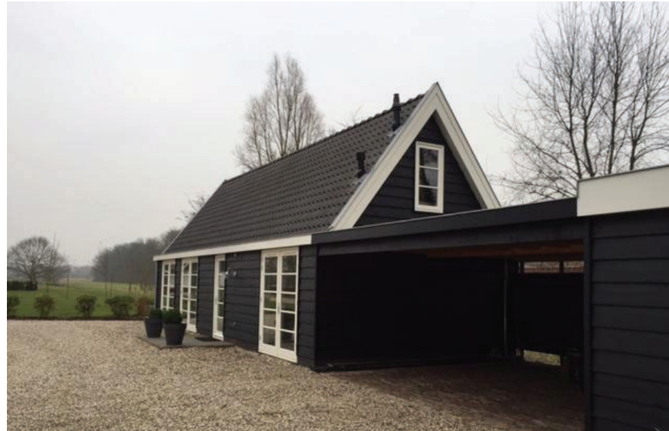
'edele schuur' vanuit het noord-westen bekeken
