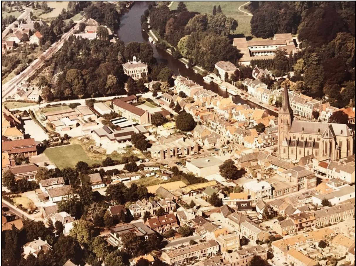
Afbeelding 5.12 Luchtfoto plangebied Harmonieplein omstreeks 1975
