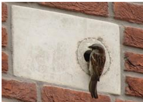
Figuur 5.1 Ingemetselde kast voor huismus (Bron: Vogelwerkgroep Nijmegen)
