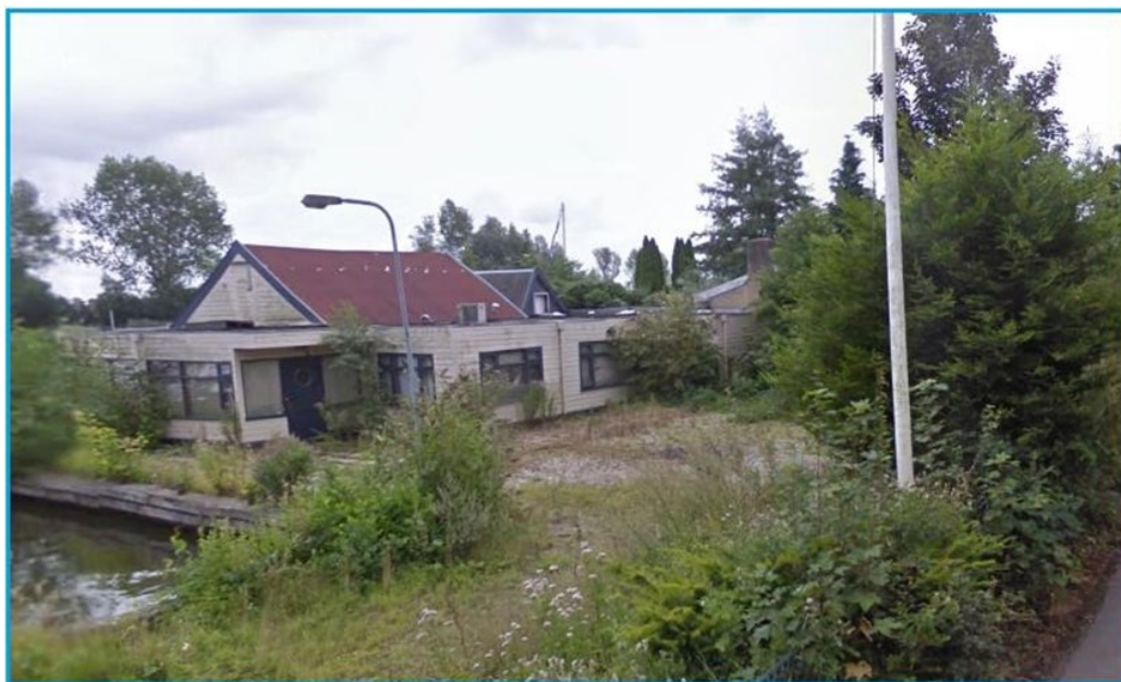
Figuur: leegstaande bedrijfspand Vreelandseweg 11 (Bron: Google Streetview).
