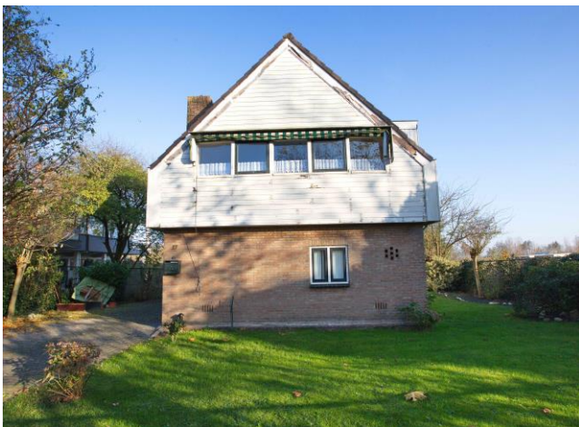
Figuur 7a: Aanzicht pand aan de Vreelandseweg 17
