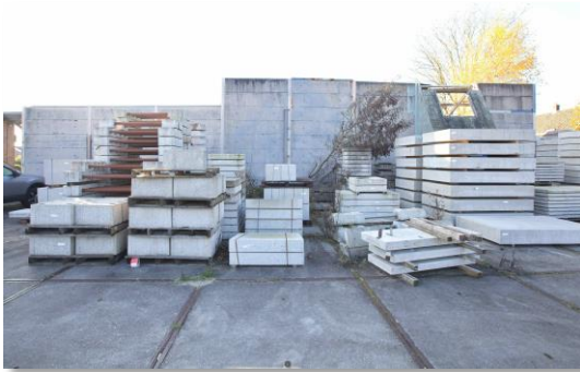
Figuur 9c: Opslag betonplaten
