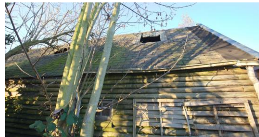
Figuur 5b: Zolder met verwijderde dakramen
