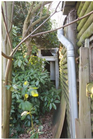
Figuur 5D: Doorgang tot het inwendige van het pand
