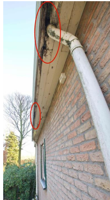
Figuur 7e: Toegangsopeningen tot pand
