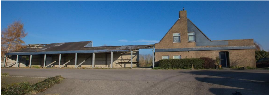
Figuur 8a: Perceel Vreelandseweg 19. Links overkapping in verval en rechts het woonhuis.
