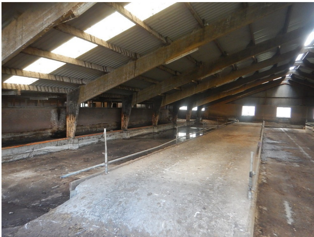
Figuur 6: Foto van het noordelijke stalgedeelte met verdiepte mestopslag.
