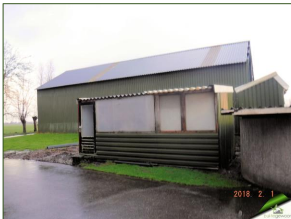
Losse schuurtjes en betonnen mest opslag
