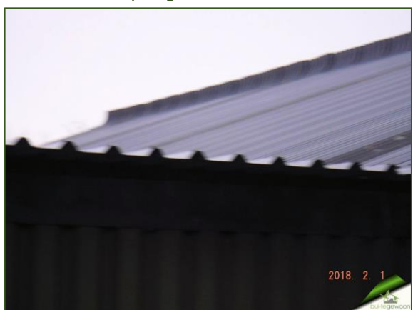
Dakconstructie meest zuidelijke opslag
