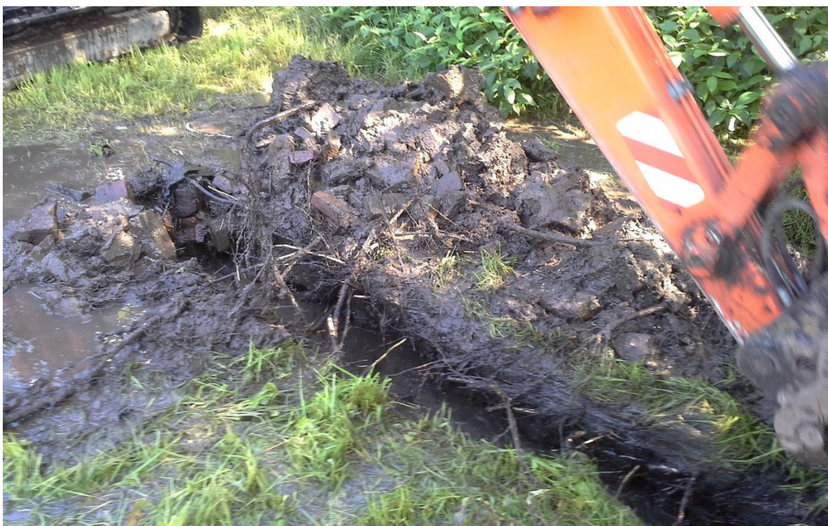
Foto 2: Detail van het aangetroffen dempingsmateriaal (gedempte watergang / RE01).
