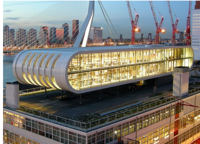
Paviljoen op het dak als bijzondere toevoeging
