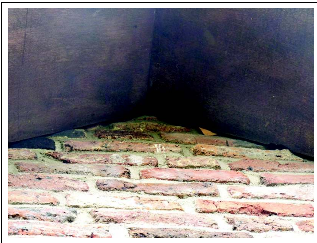
Foto 4. opening tussen muur en dakrand, geschikt voor soort als gewone grootoorvleermuis
