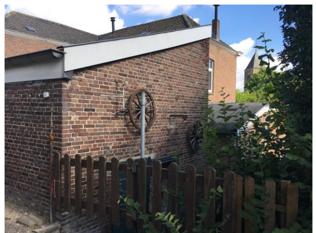
Foto 6 Aanzicht achterzijde gebouw met doorgang oostzijde locatie
