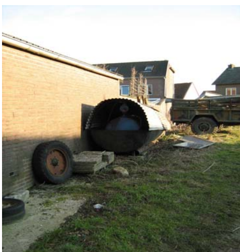
Dieseltank in lekbak
