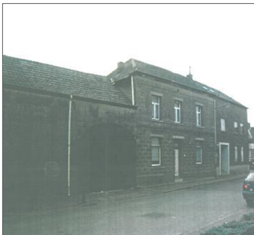
voorgevel Pastoor Brouwersstraat 12
