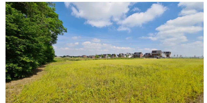
Figuur 9: Zuidelijk deel plangebied, gezien vanuit het zuiden
