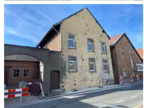
7 Foto's bestaande toestand Projectadres: Pastoor Brouwersstraat 3, 6269 BD Margraten
