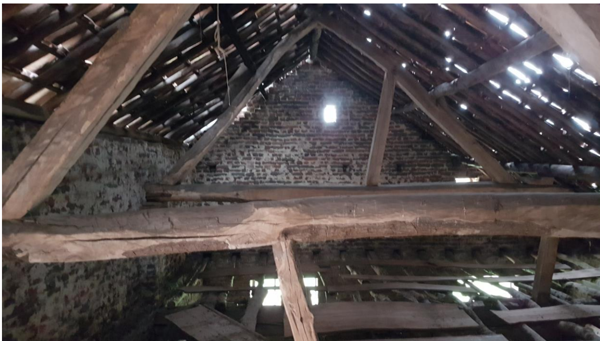
Foto 5: dakconstructie van de varkenstallen en hooizolder wat verbouwd gaat worden. n.b. is het hooi hier al weg gehaald.
