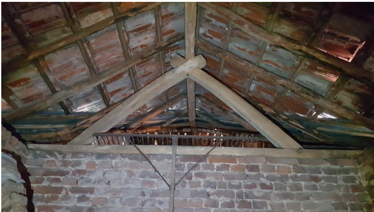
Foto 3: dakconstructie boven de poort.
