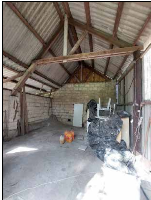
Figuur 4.1 Weergave van de onderzijde van het dak. Links is zichtbaar dat de ruimtes tussen asbest dakplaten en de dakbalken enkele centimeters bedraagt waardoor vleermuizen kwetsbaar zijn voor predatoren. Links en rechts is zichtbaar dat de asbestplaten niet steunen op een dakbeschoot.
