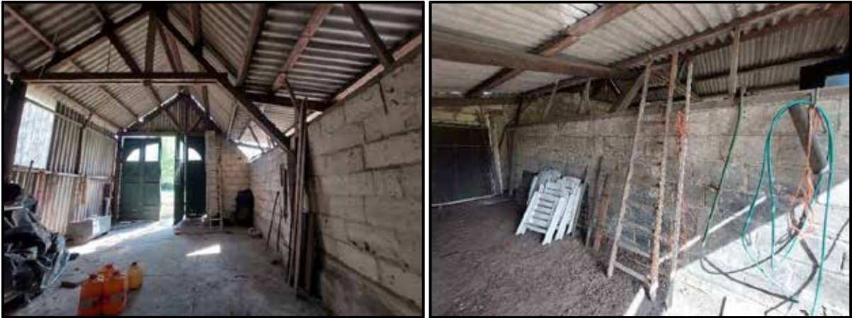
Figuur 2.4 Weergave binnenzijde van de te slopen schuur.
