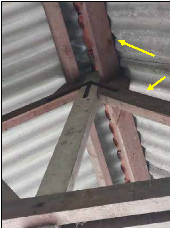
Figuur 4.1 Weergave van de onderzijde van het dak. Links is zichtbaar dat de ruimtes tussen asbest dakplaten en de dakbalken enkele centimeters bedraagt waardoor vleermuizen kwetsbaar zijn voor predatoren. Links en rechts is zichtbaar dat de asbestplaten niet steunen op een dakbeschoot.
