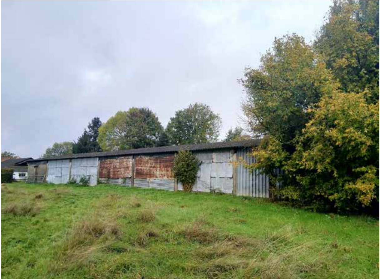
Foto 3: Overzichtsfoto van de zuidelijke zijde van de kapschuur.
