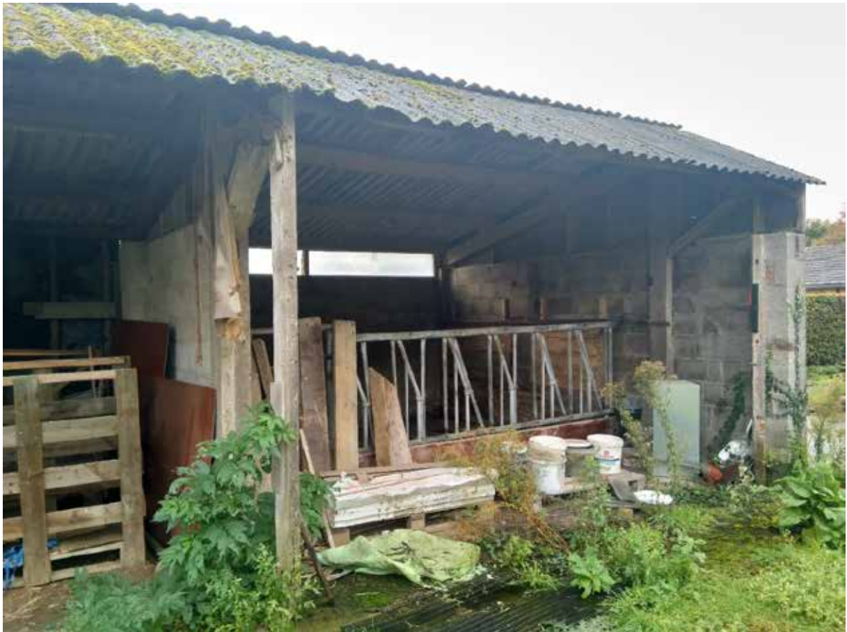
Foto 11: Impressie van de westelijke zijde van de kapschuur met midden onder één van de platen op de grond.
