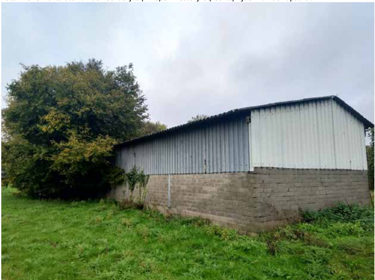
Foto 2: Overzichtsfoto van de oostelijke (rechts) en zuidelijke (links) zijden van de kapschuur.
