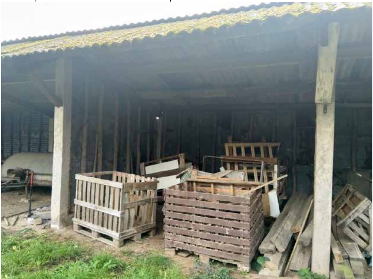
Foto 6: De pallets met haardhout en een stapel houten balken in het middelste deel van de kapschuur.
