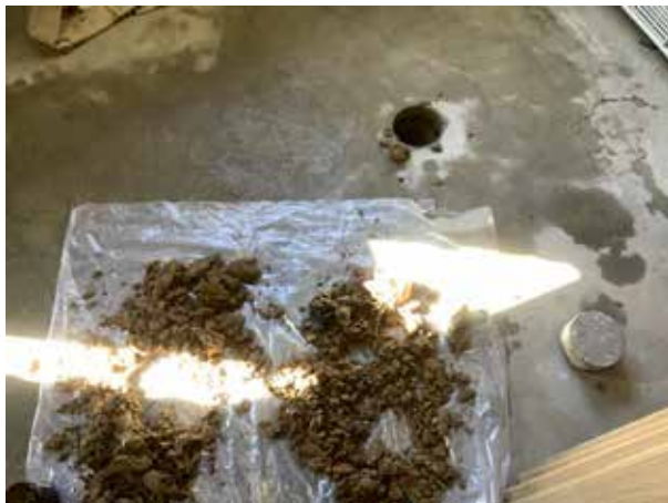
Foto 1 Boring ter plaatse van bestrijdingsmiddelenopslag
