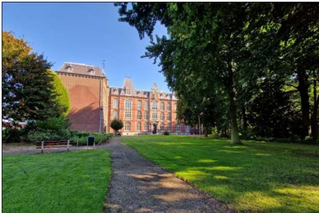
De voorgevel (zuidgevel) van het Ursulinenklooster
