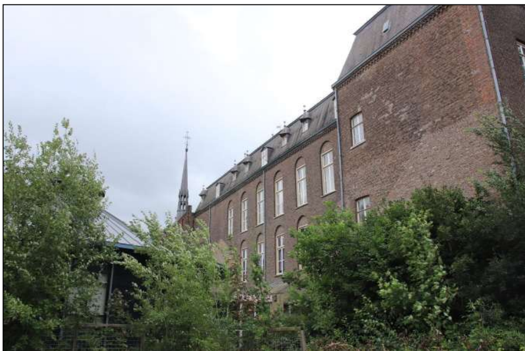
Noordzijde kloostergebouw (bron: Ecolybrum)
