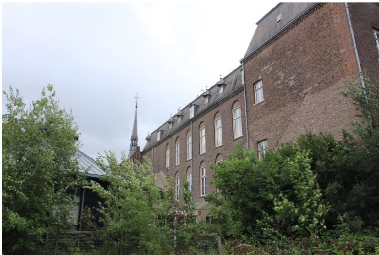
Foto 1: Zicht op het complex op de noordzijde
