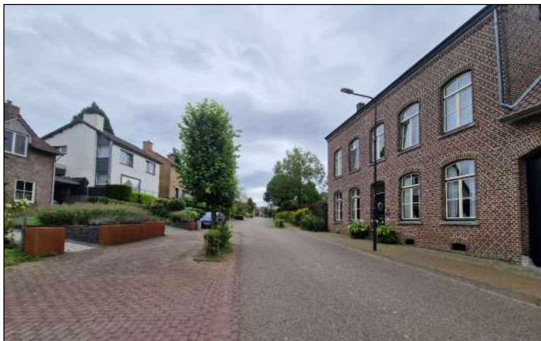
De Dorpsstraat in oostelijke richting, ter hoogte van het besluitgebied
