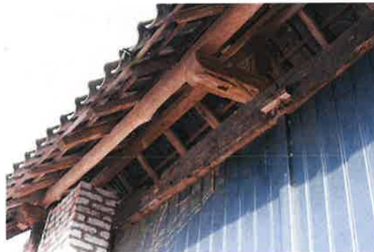
2. De oorspronkelijke dakconstructie
