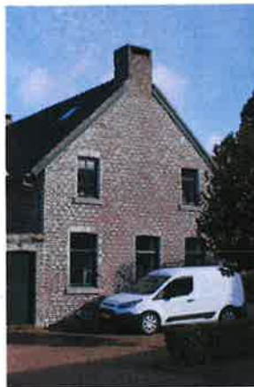
6. De kopgevel aan de straat
