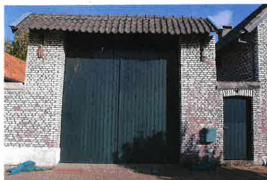
1. De poort met rechts de secundaire toegang voor voetgangers
