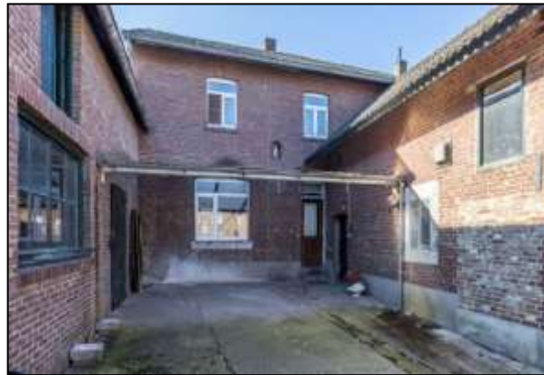
Zicht vanaf binnenplaats
