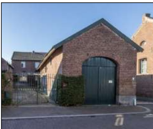
Frontaal zicht vanaf Breusterstraat
