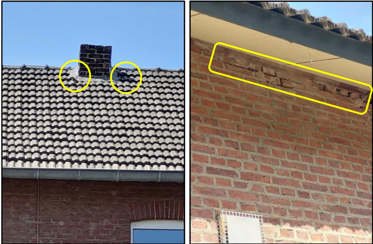
Figuur 4.4 Links: weergave van verbogen daklood ter plaatse van de woning binnen de gele markering. Rechts: weergave van dilatatievoegen ter plaatse van de schuur binnen de gele markering. Deze locaties zijn geschikt als verblijfplaatsen van vleermuizen.
