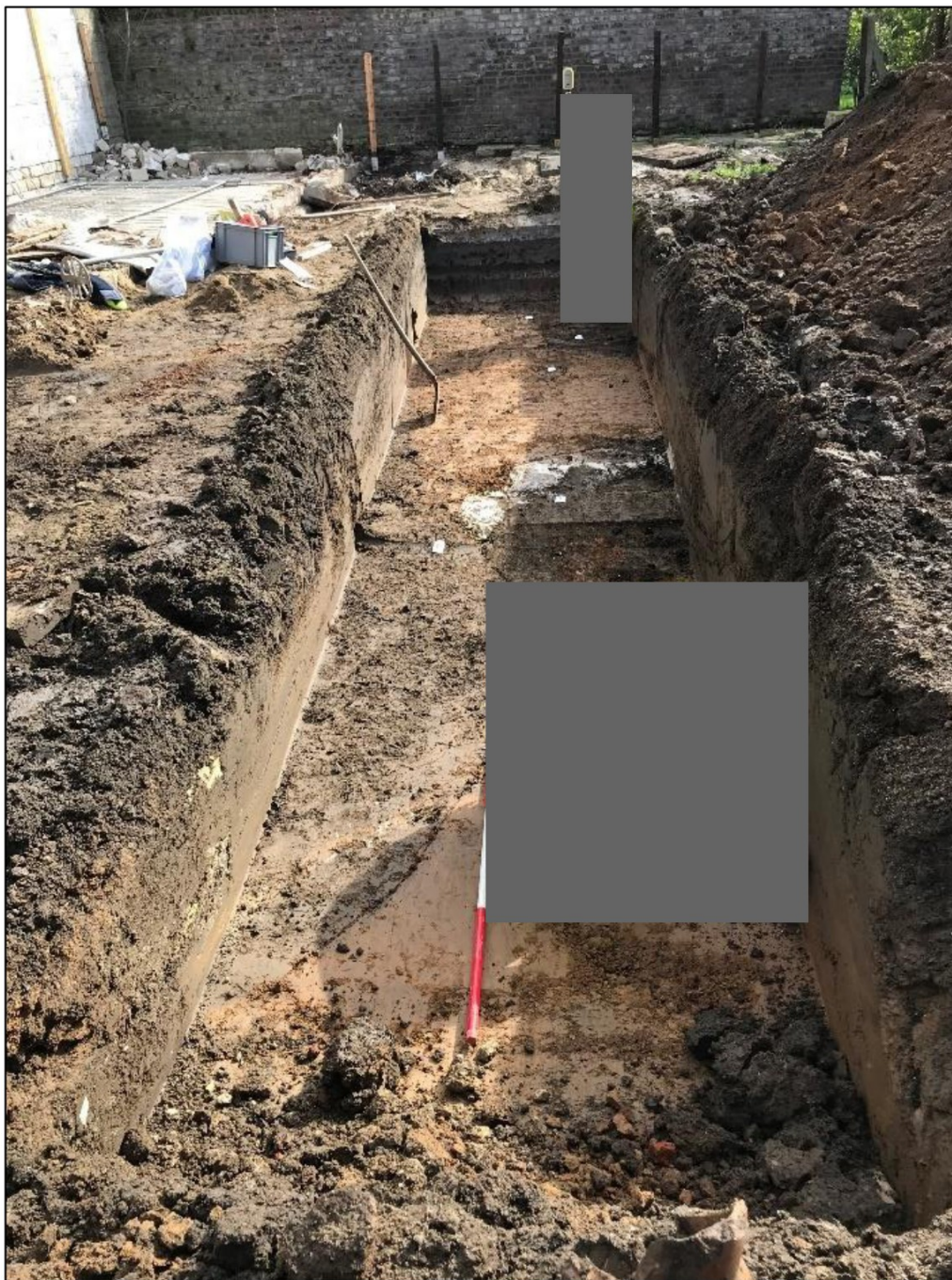
Figuur 4. Overzichtsfoto van werkput 2 (gezien richting het oosten).
