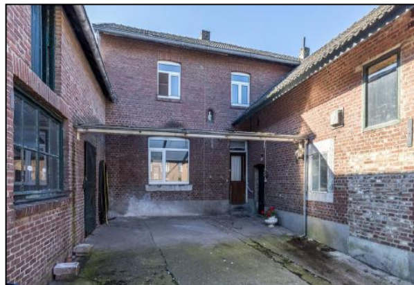
Zicht vanaf binnenplaats
