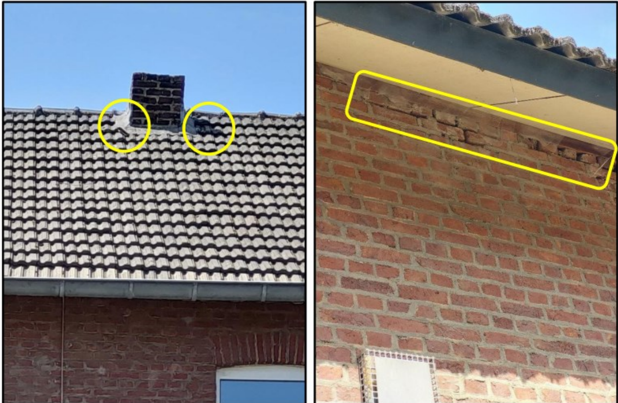
Figuur 4.4 Links: weergave van verbogen daklood ter plaatse van de woning binnen de gele markering. Rechts: weergave van dilatatievoegen ter plaatse van de schuur binnen de gele markering. Deze locaties zijn geschikt als verblijfplaatsen van vleermuizen.
