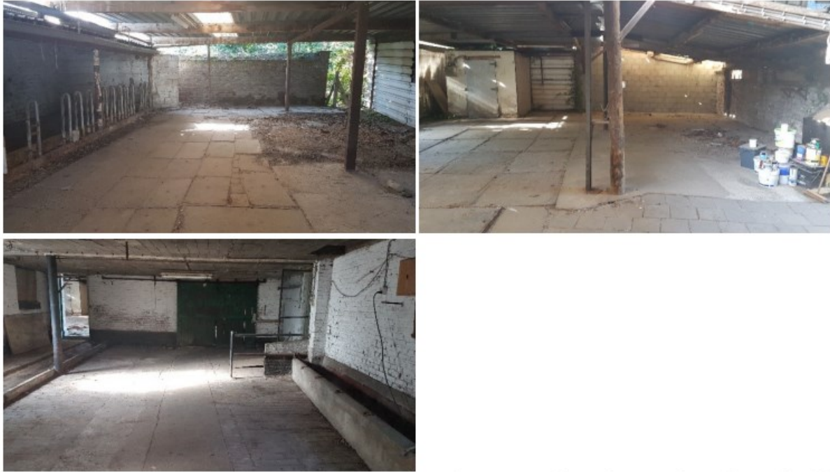
Figuur 3b: foto's van het interieur van de te verbouwen schuur binnen het plangebied. 4
