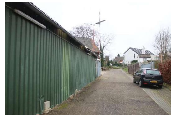
Figuur 3.3: Op het terrein is een loods aanwezig.
