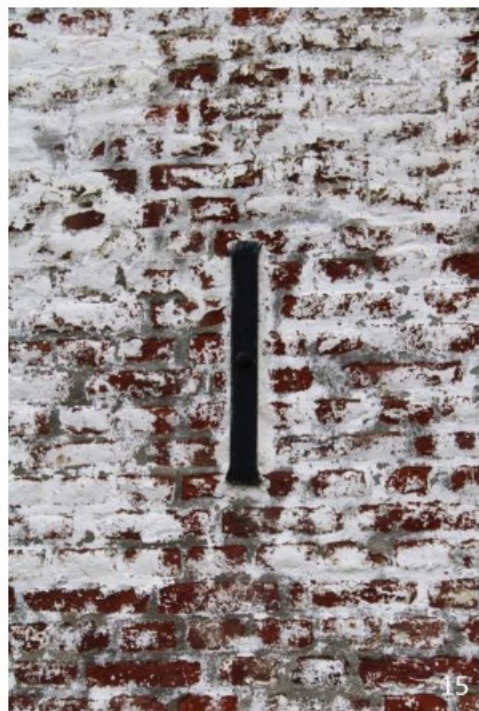
15. Detail van een van de ankerijzers
