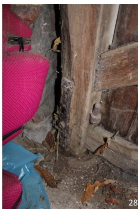
26. Blik door de poort richting achterzijde 27. De poort 28. Detail van het taatsgehang met zeskantbouten, zoals typisch voor de 19 de eeuw
