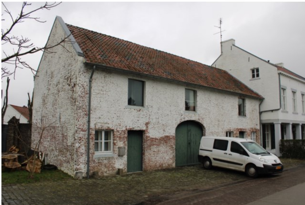
1. Blik op de gevel aan de Rijksweg
