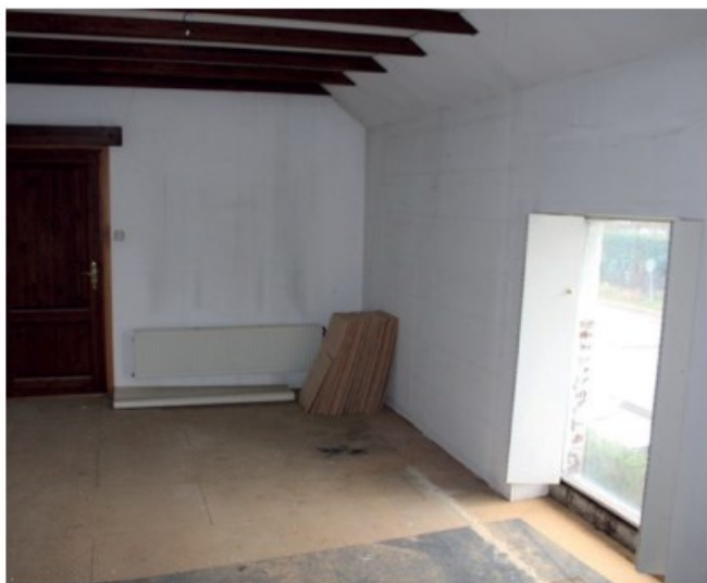
Afbeelding 10 Het interieur is in de jaren 80 geheel aangepast. Zo zijn de vloeren, dak, trappen en binnendeuren destijds vervangen.
