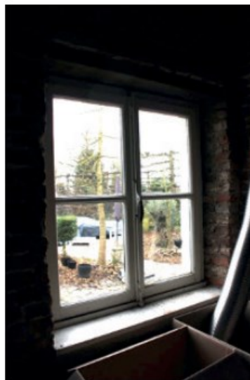
Afbeelding 11 Stolpraam (uit 1980) aan de binnenzijde.
