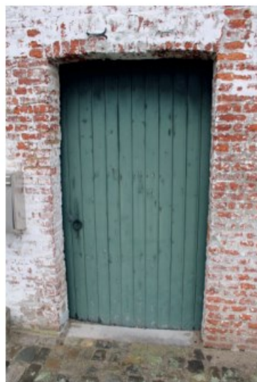
Afbeelding 4 Een van de deuren die aan de voorzijde zijn gepositioneerd. De onderdorpel is van Naamse steen.
