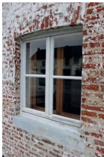
Afbeelding 6 Een van de stolpramen (uit de jaren 80) die aan de voorzijde zijn gepositioneerd. De onderdorpel is van Naamse steen.
