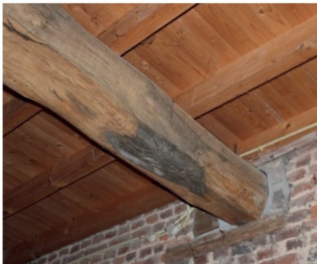
Afbeelding 9 De oplegging van de ankerbalk in het interieur. De balklaag vloer is later vervangen.
