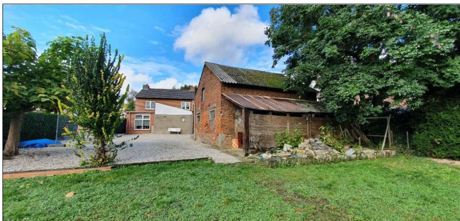
Foto's bestaande situatie
