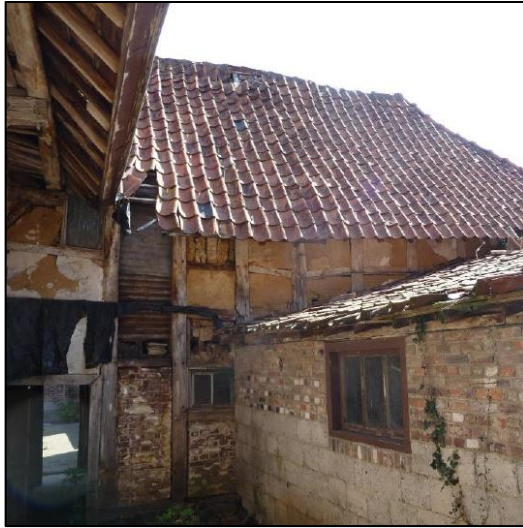
Binnenhofje (1) (bron: SatijnPlus Architecten)
