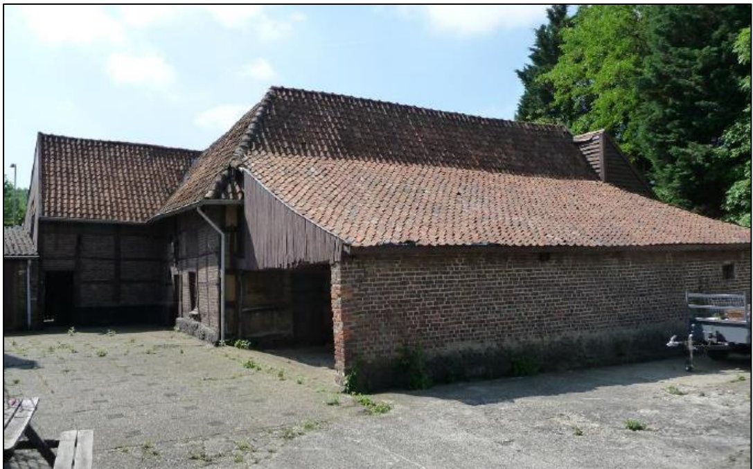
Westzijde (linker zijde) carréboerderij (bron: SatijnPlus Architecten)
