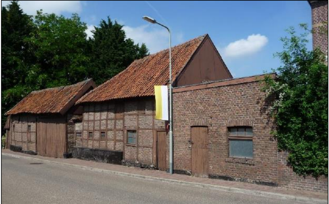
Carréboerderij straatzijde (bron: SatijnPlus Architecten)
