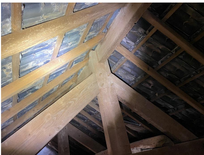
Foto 3: Dakconstructie op zolder van het gebouw
