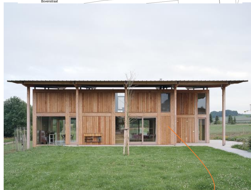
nieuwbouw 'Schop' volledig uit hout
