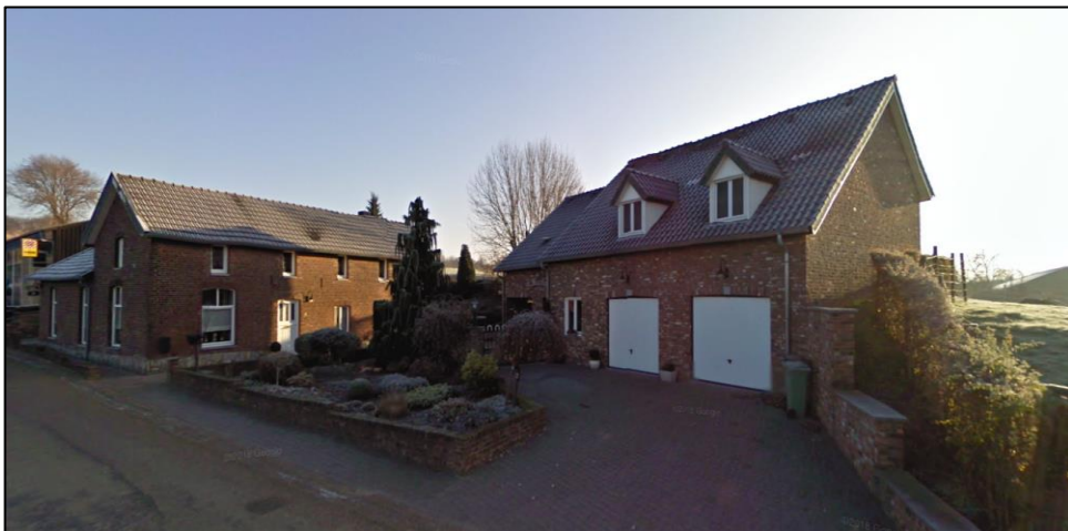
Foto's bestaande situatie
