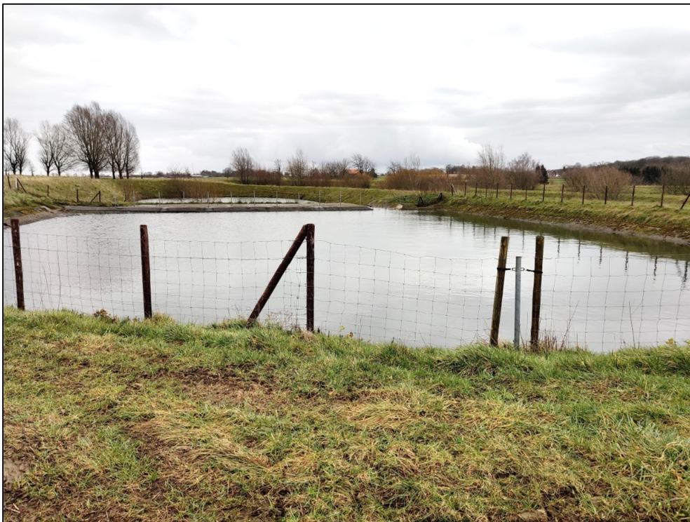
Figuur 4: Zicht op het functionele deel van de blusvijver.
