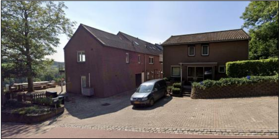
Straatzijde vakantieappartementencomplex Mheerelindje 8
